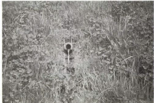
写－６ ダム建設付帯工事－排水－（北海道）
