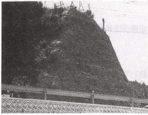
写－１ 道路拡幅工事（石川県）
